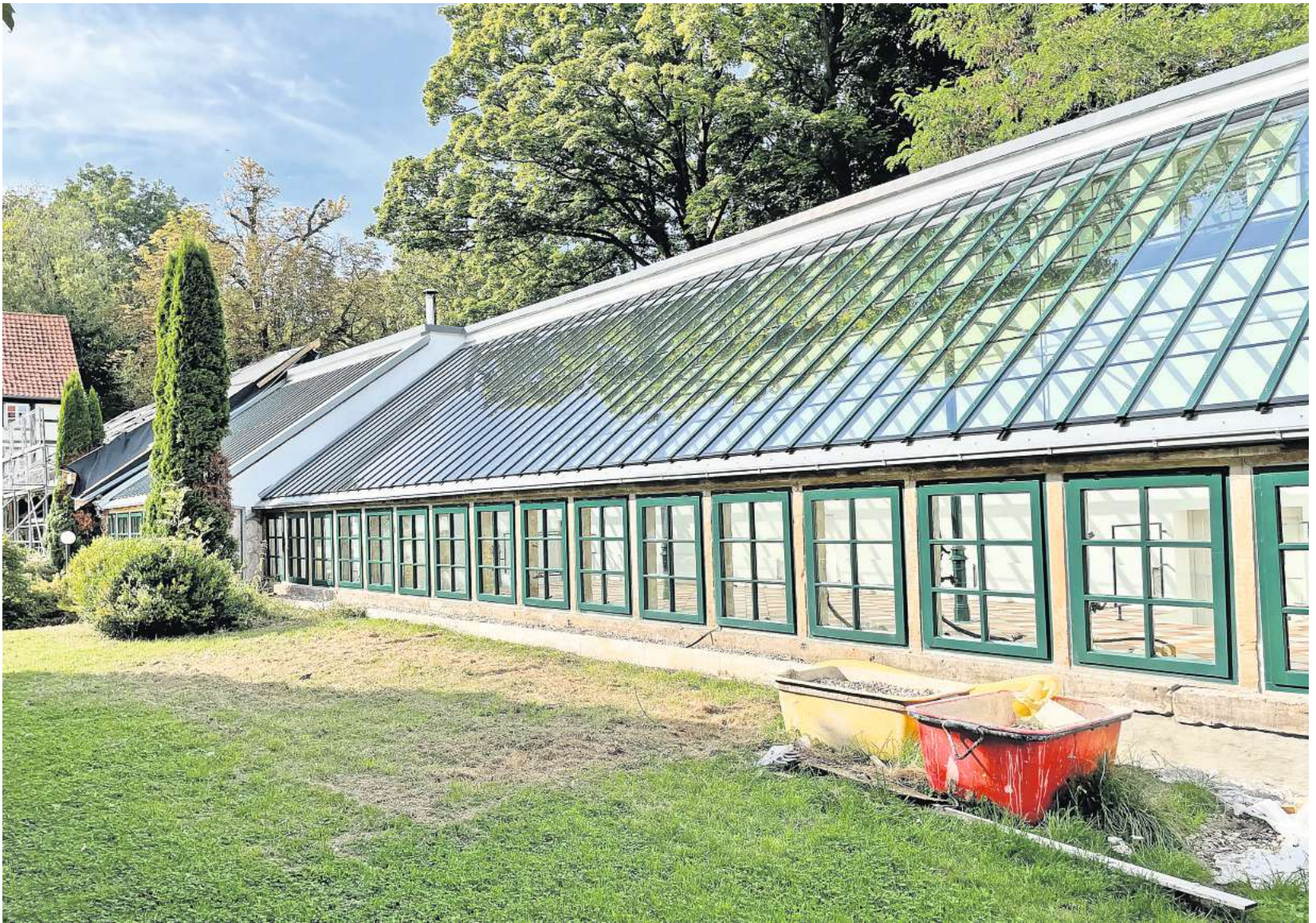
Es geht voran: Das Baudach am Glashaus ist bereits entfernt und auf einer Seite ist das Glasdach fertig.
