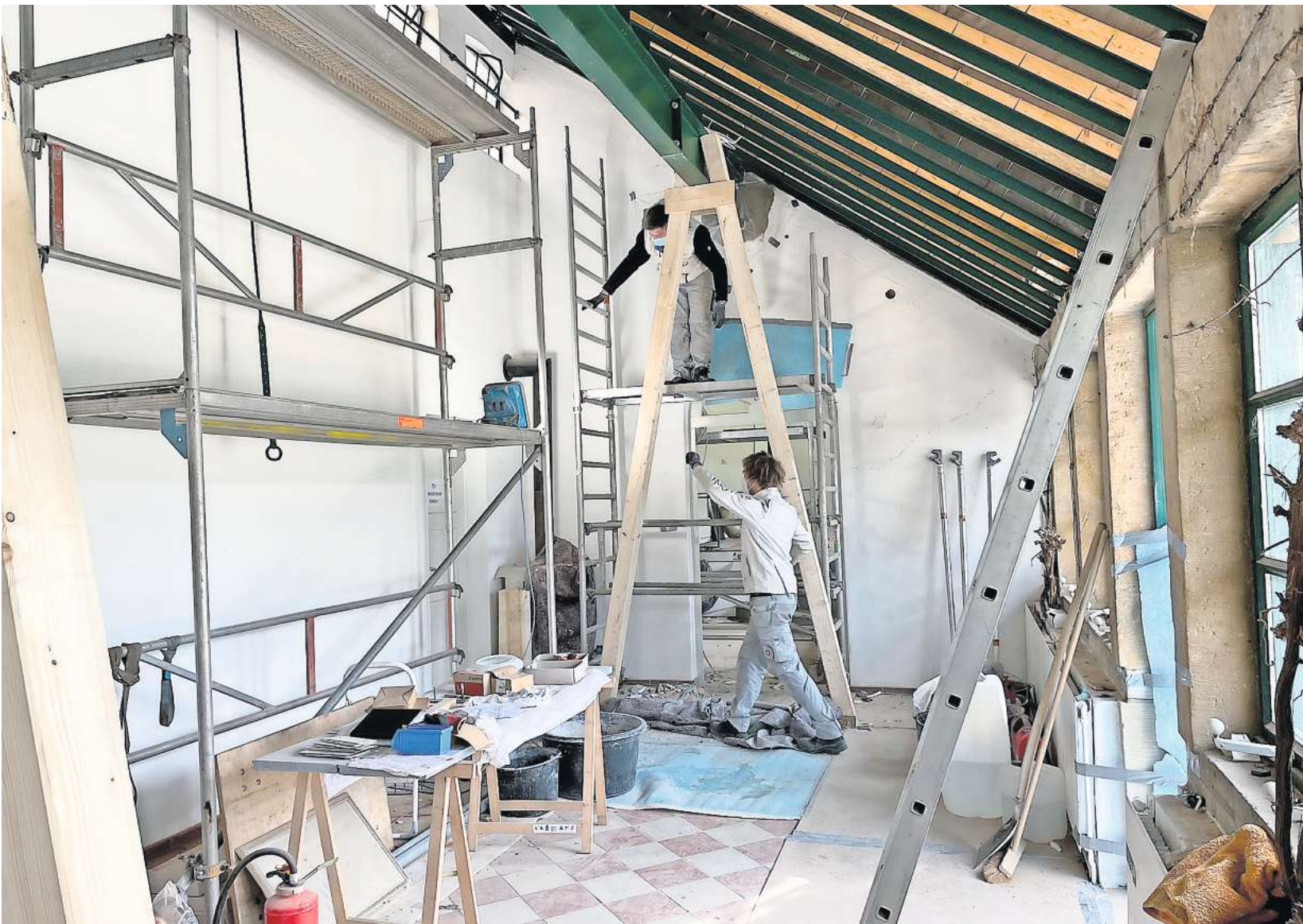
Mitarbeiter des Baugeschäfts Voss haben im Glashaus einen neuen Stahlträger eingezogen.
