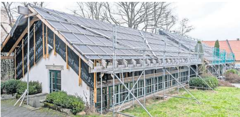
Anfang Mai soll die Stahlkonstruktion auf das Feigenhaus des Glashauses installiert werden.
