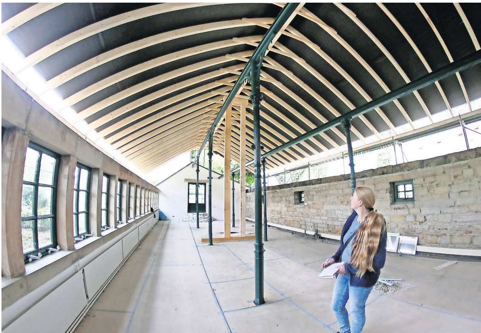
Iris Adelhelm von der Gemeinde Holle sieht sich den Stand der Bauarbeiten im Derneburger Glashaus an.
